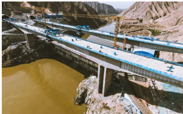
▲ 连霍高速什川黄河特大桥左幅合拢
