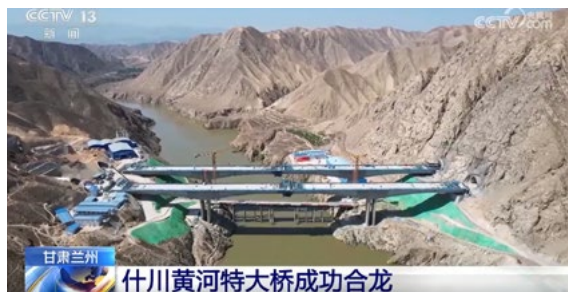
▲什川黄河特大桥成功合龙
