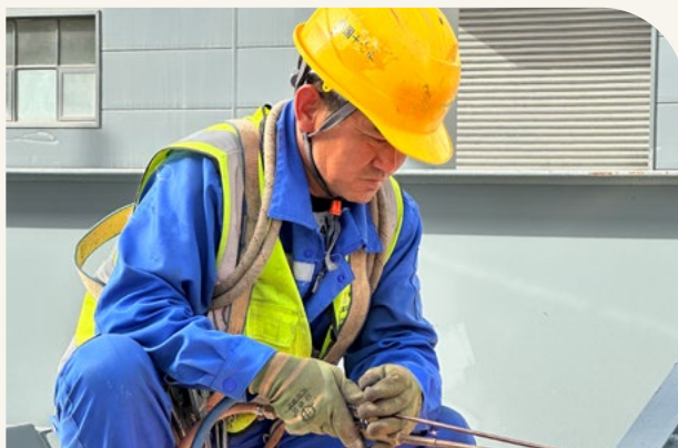
▲ 安徽滁芜产业园项目
