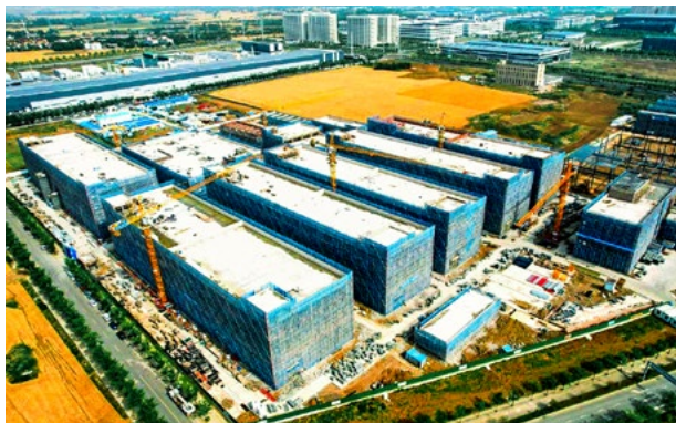
▲ 明光表面处理中心（一期）项目全面封顶
