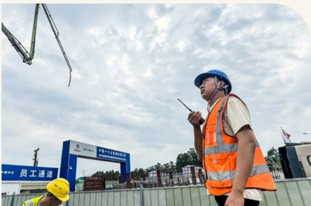
▲ 中储粮四川新津直属库项目
